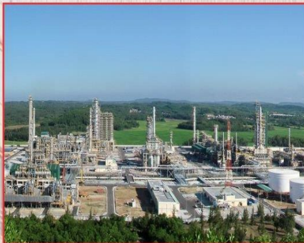
Nhà Máy Lọc Dầu Dung Quất Dung Quat refinery factory
